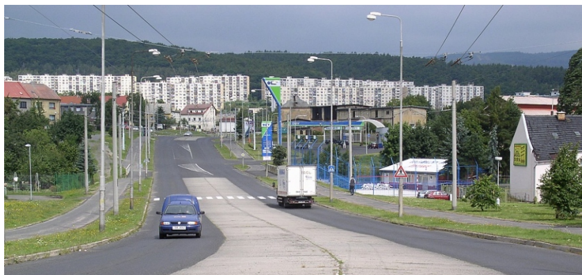
Pohled na jirkovské sídliště Nové Ervěnice, které sice nepatří k nejnovějším, ale přesto je o byty ve zdejší lokalitě zájem právě díky jejich zatím nízké ceně.
